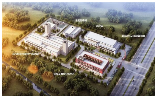
图 2 临港试验基地
